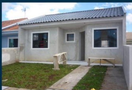
CONSTRUÇÕES E REFORMAS DE OBRAS EM ALVENARIA
