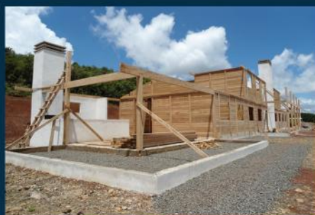
CONSTRUÇÕES E REFORMAS DE OBRAS EM MADEIRA
