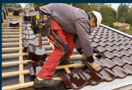
CONSTRUÇÕES E REFORMAS DE COBERTURAS E TELHADOS
