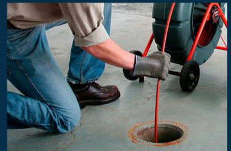
SERVIÇOS DE ESGOTO
