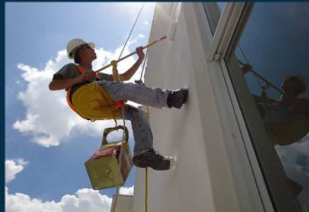
SERVIÇO DE PINTURA EM EDIFÍCIOS
