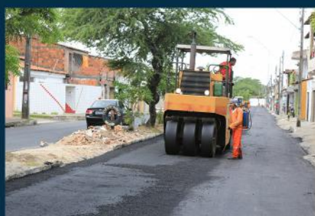
CONSTRUÇÃO E PAVIMENTAÇÃO DE VIAS PÚBLICAS
