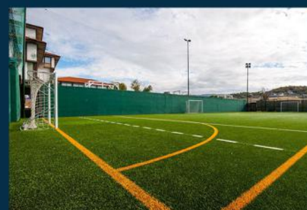
CONSTRUÇÕES E REFORMAS DE QUADRAS ESPORTIVAS
